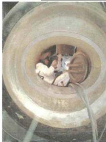
Travail de soudure dans le ballon chaudière
