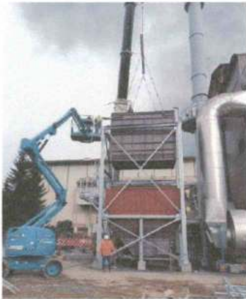
Installation du catalyseur.
