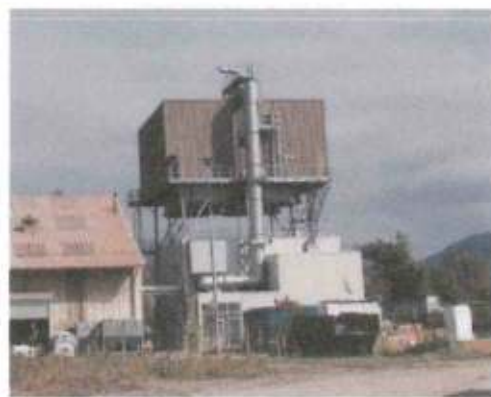
Bâtiment GTA après travaux - vue ouest.
