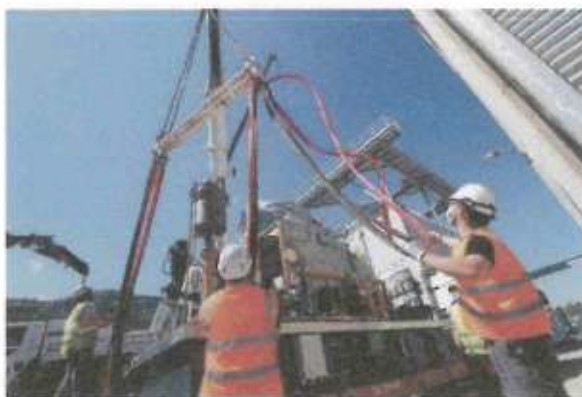
Installation de la turbine
