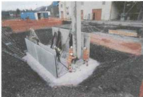
Génie-civil du bâtiment GTA
