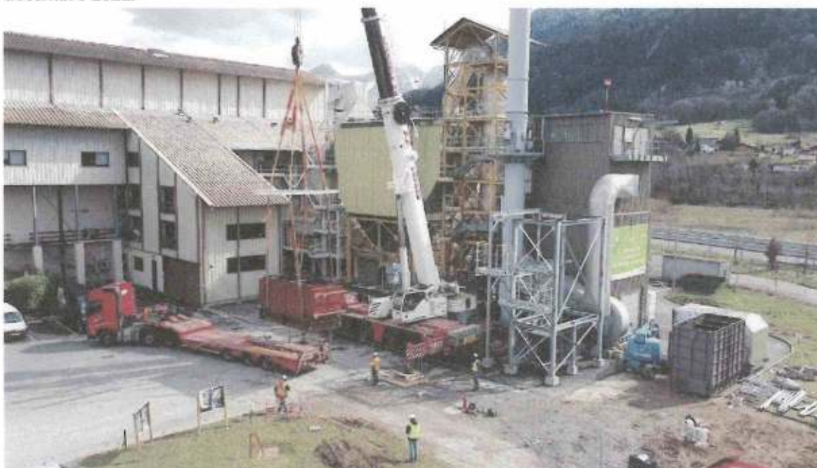
Vue générale du chantier côté éco-finiisseur et catalyseur.
