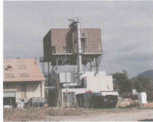
Bâtiment GTA après travaux - vue ouest.
