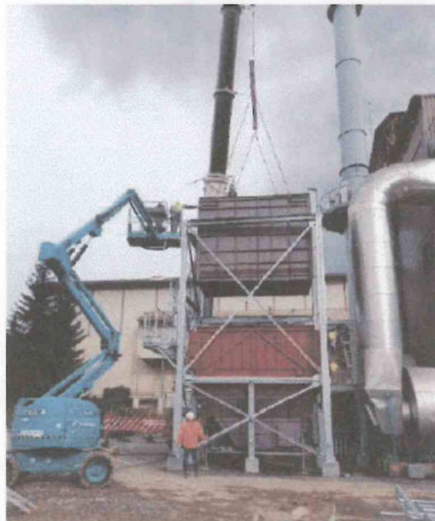
Installation du catalyseur.
