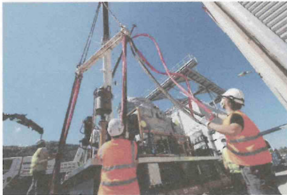
Installation de la turbine
