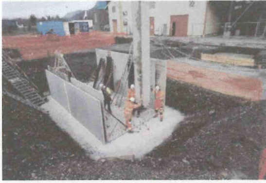
Génie-civil du bâtiment GTA
