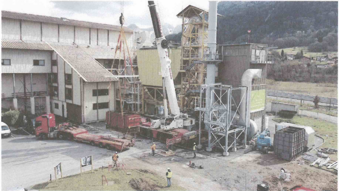
Vue générale du chantier côté éco-finisseur et catalyseur.
